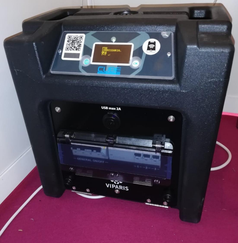
COFFRET ELECTRIQUE 3 à 10kw
